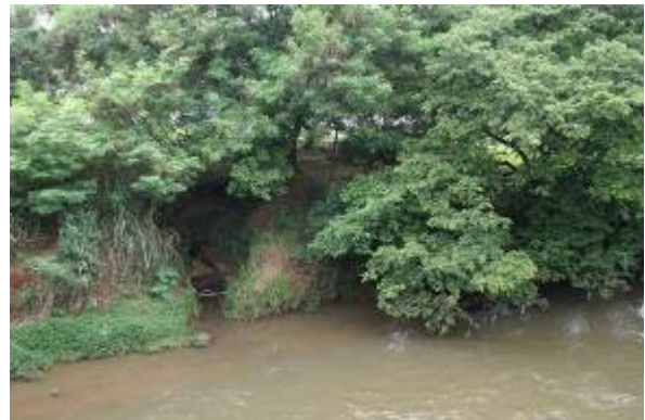
Figura 4: Vista Geral da Área 1. Fonte: Acervo do autor.
