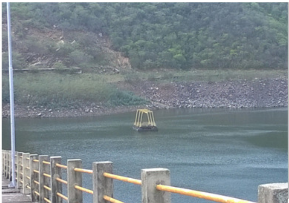
Figura 2 - Flutuante da COMPESA, utilizado como ponto de captação de água para abastecimento. Fonte: Autora do Trabalho, 2013.
