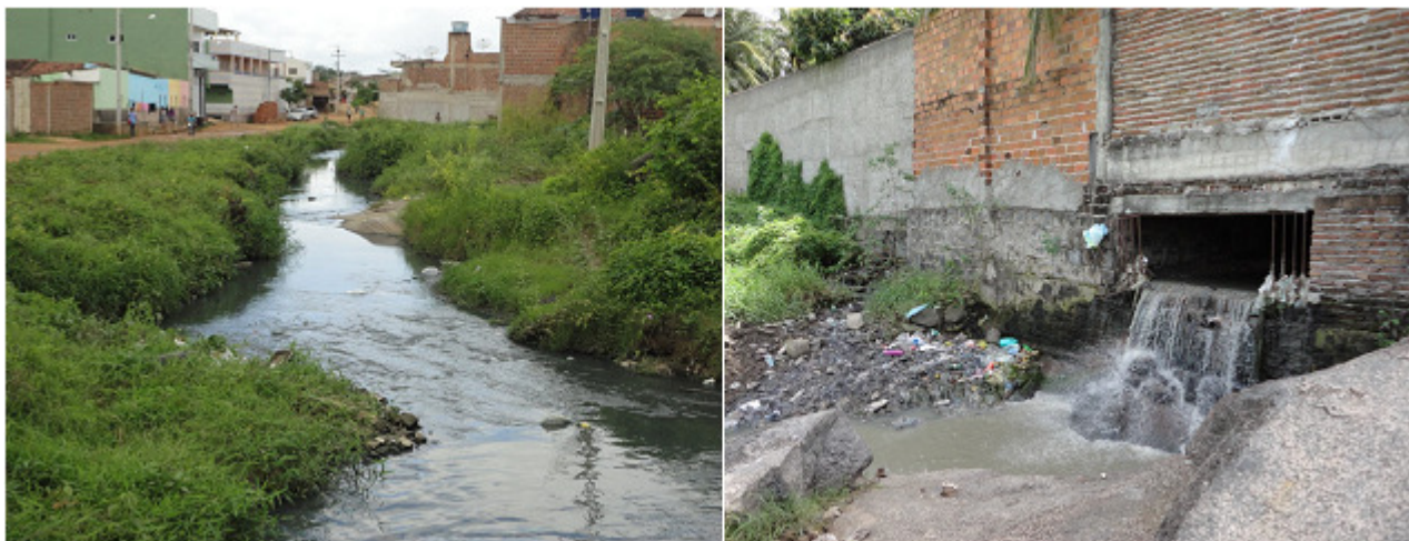
Figura 4 - Canal que conduz esgoto bruto para o rio Capibaribe e lançamento de esgoto bruto direto no rio, em Toritama-PE. Fonte: Barbosa, 2012.
