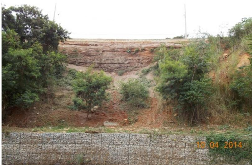
**Figura VII: erosão na encosta próxima ao ponto 5. Fonte: próprios autores (2014).**
