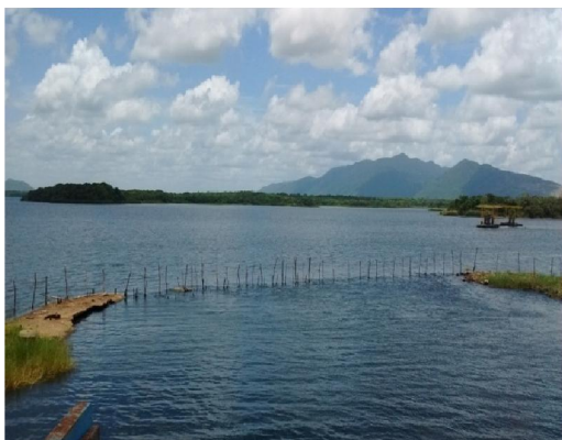
Figura 3 - Captação - Açude Gavião, Pacatuba-CE. Fonte: Autora do trabalho.
