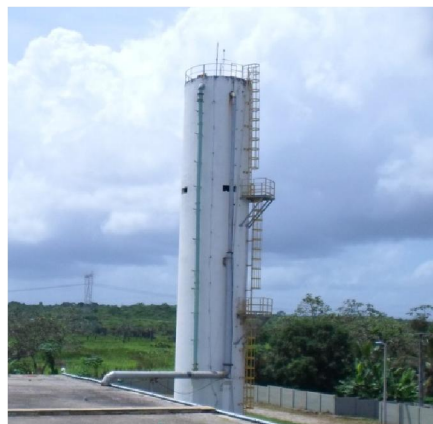
Figura 6 - Reservatório da ETA Gavião, Pacatuba-CE, 2016. Fonte: Autora do trabalho.
