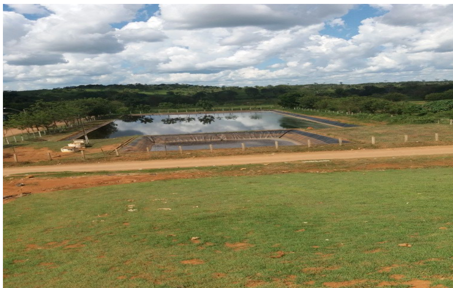
Figura 4. Sistema de tratamento de efluentes gerados no aterro sanitário. Fonte: Autor do Trabalho.
