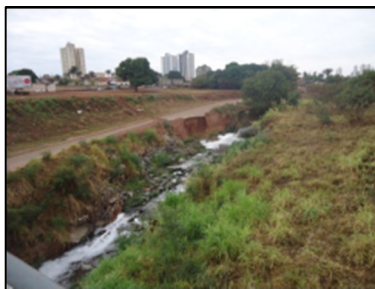
Figura 3. Vista parcial do córrego sem mata ciliar, processo erosivo nas margens e parte do gabião destruído. Foto:Roque, 2018.
