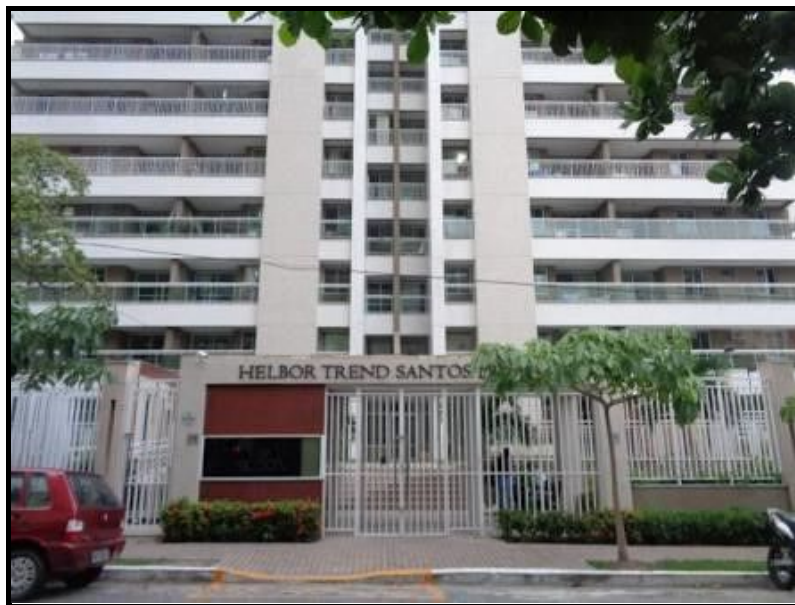
Figura 1: Fachada do Condomínio Helbor Trend Santos Dumont. Fonte: Autora, 2016.
