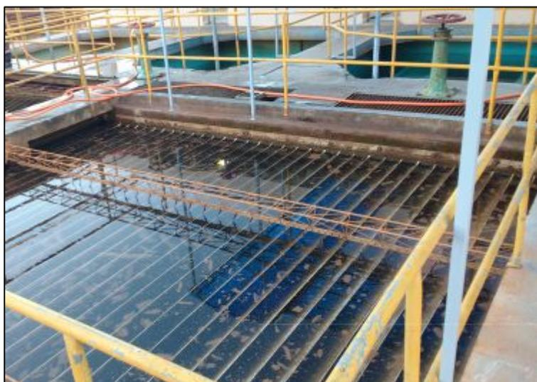
Figura 1: Decantador (à frente) e filtros (ao fundo) da ETA estudada. Fonte: Autores do trabalho.
