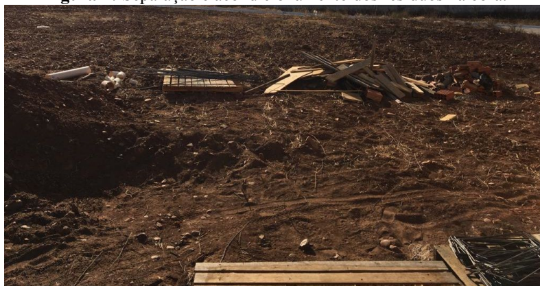
Figura 1: Separação e acondicionamento dos resíduos na obra.
