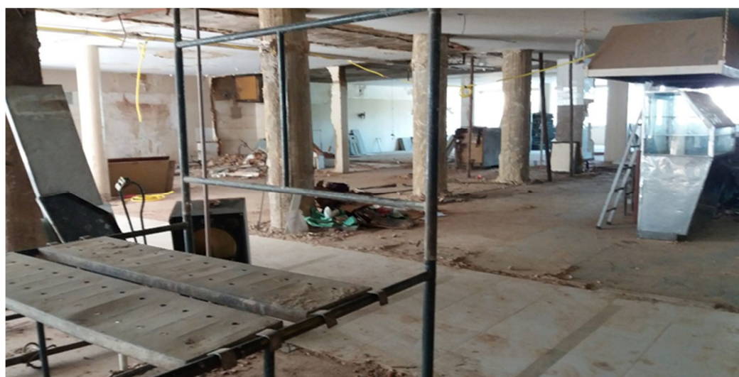
Figura 4: Área interna do hotel em reforma. Fonte: Própria autora, 2017
