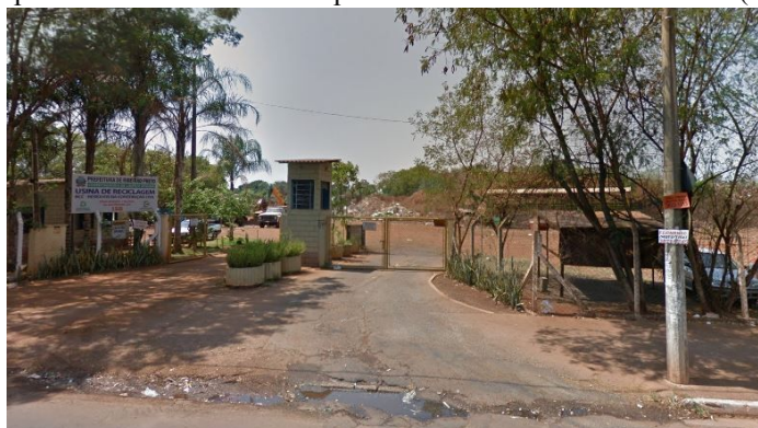
Figura 8: Usina de reciclagem de RCD de Ribeirão Preto – Fonte: Autoria própria (2019)
