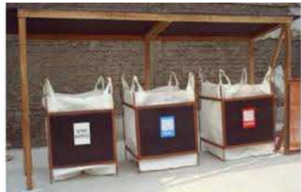
Figura 5: armazenamento indicado para os resíduos em obra. Fonte: Sítio Pini Editora.
