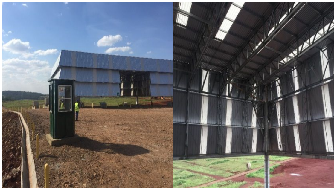
Figura 1: Sistema de captação de água pluvial do CTR Itambé. Fonte: Autor de Trabalho.
