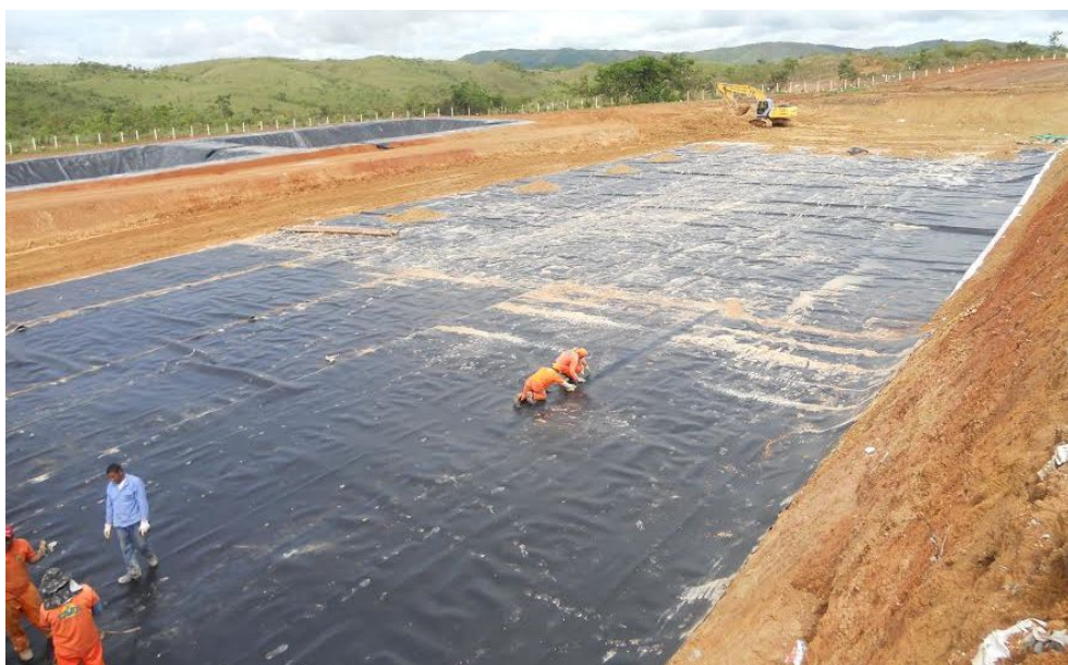
Figura 9: Impermeabilização com Geomembrana. Fonte: Google Imagens.
