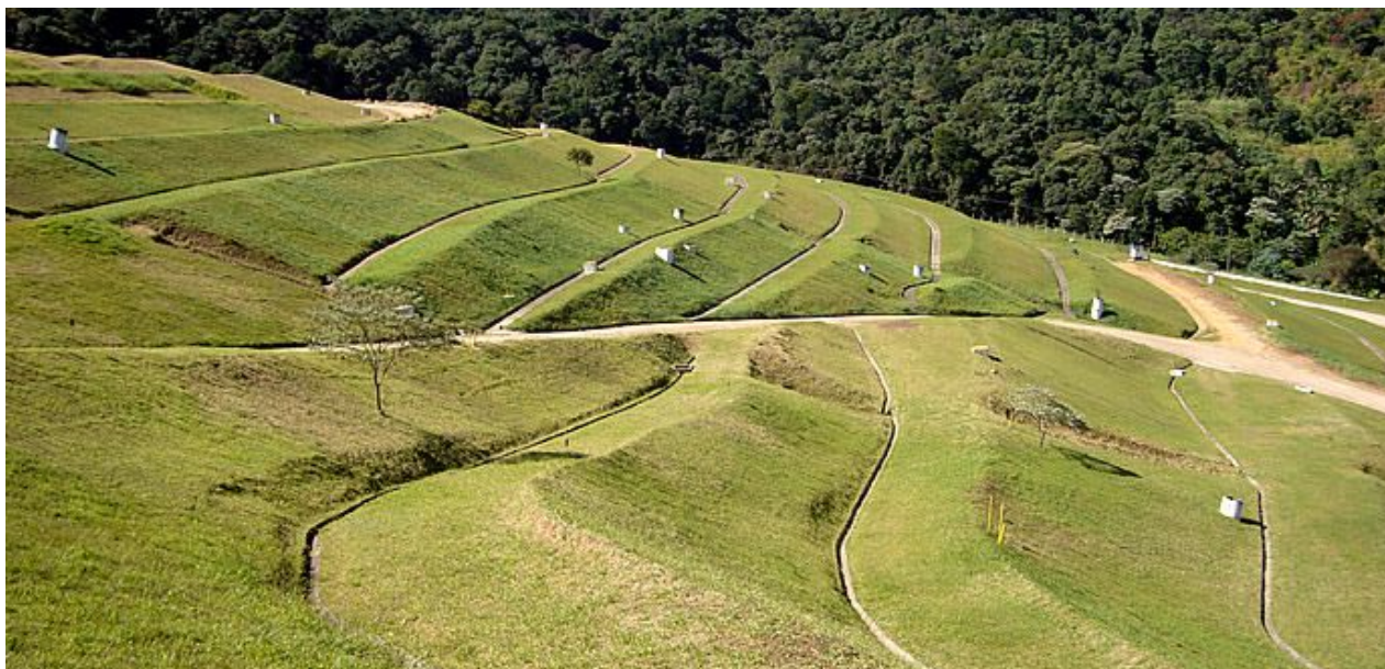
Figura 11: Drenos superficiais. Fonte: Google Imagens.
