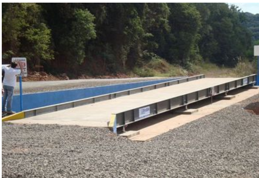
Figura 7: Balança para pesagem dos caminhões de resíduo. Fonte: Google Imagens.
