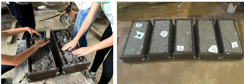
**Figura 3: (a) Processo de moldagem dos artefatos; (b) Blocos aguardando secagem para desforma. Fonte: Autor do Trabalho.**
