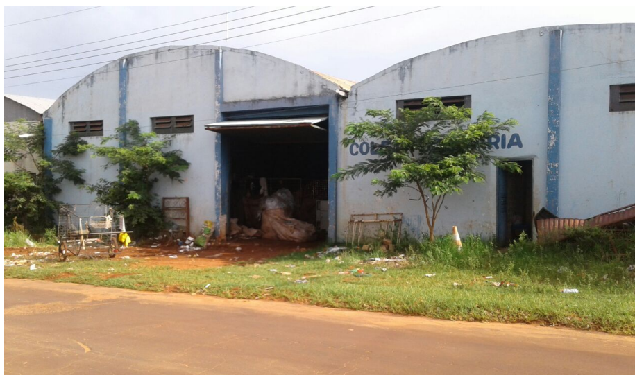
Figura 4: Sede da ARAM. Fonte: Autor do Trabalho.
