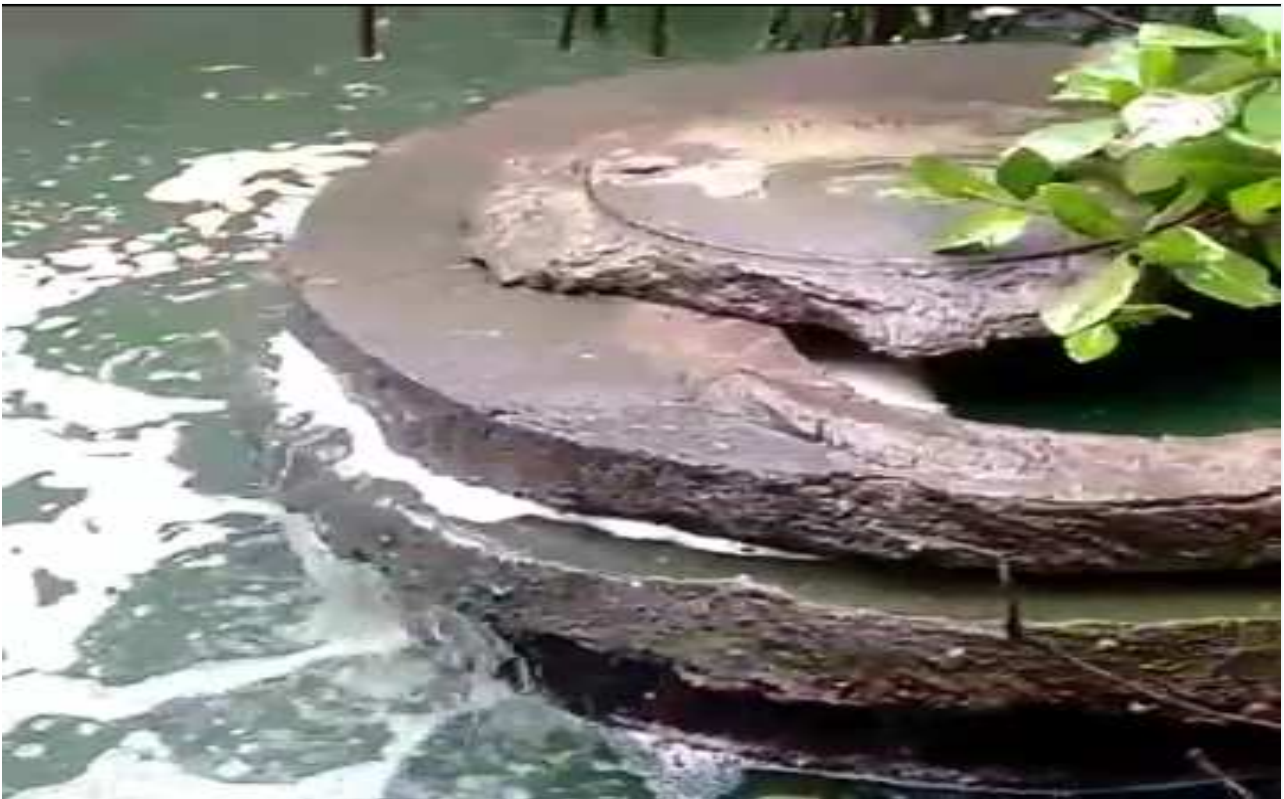
Foto 8 - Manilha despejando efluentes dentro do mangue - Coordenadas Geográficas: 8°44'2'' S e 35° 6' 18'' W Fonte: Souza. J. L. F de
