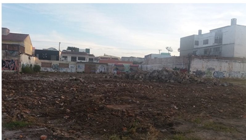
Figura 3 – Registro fotográfico da área de estudo (Avaliação Preliminar).
