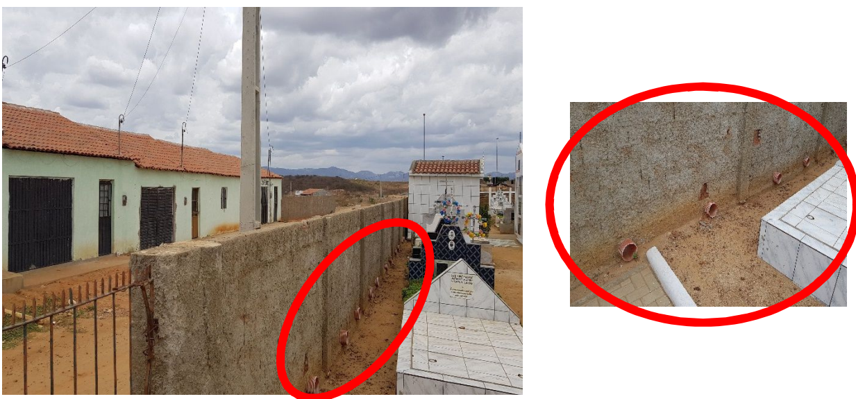
Figura 6: Sistema de Drenagem Pluvial. Fonte: Autores.
