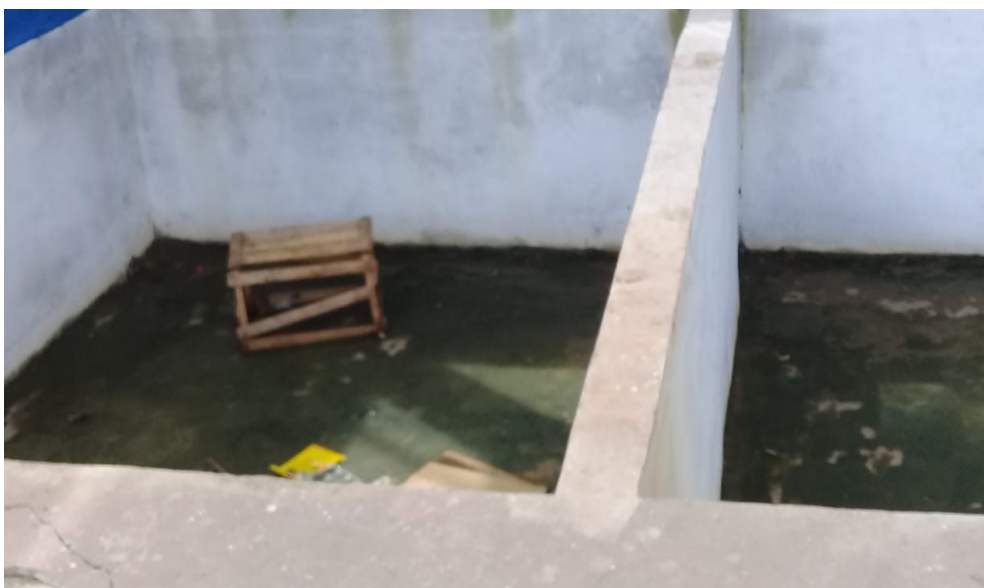
Figura 4: Espaço designado aos côntainers . Fonte: Autores, 2020.
