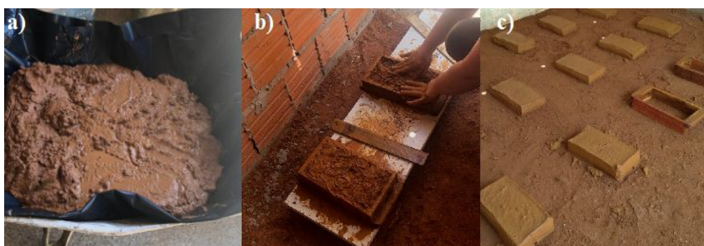
Figura 01: Processo de moldagem: (a) Massa preparada, (b) moldagem e regularização e (c) blocos recém desmoldados. Fonte: Autor do Trabalho.
