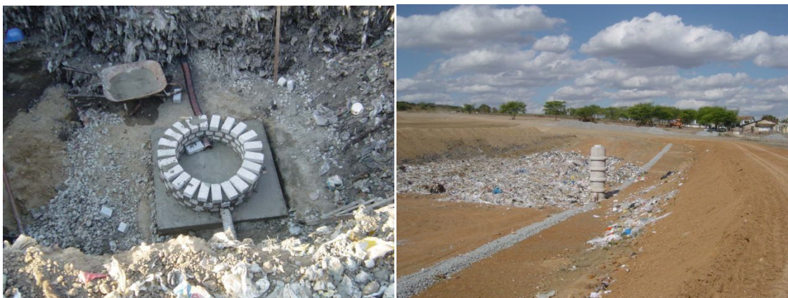
Figuras 4 e 5: Instalação dos sistemas de drenagem.
