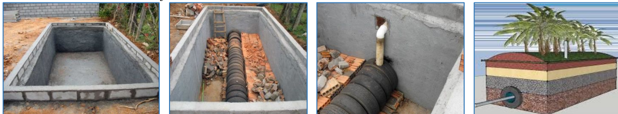
Figura 1: (A) Disposição dos pneus de forma linear, a fim de criar um túnel (câmara bio-séptica) e na parte externa, complementação com cascalhos, material com alta porosidade para facilitar na transferência natural do efluente; (B) Câmara Bio-Séptica; (C) Instalação do cano de PVC que irá efetuar a transferência da água negra do vaso até o interior da câmara séptica, (D) Camadas restantes e plantio
