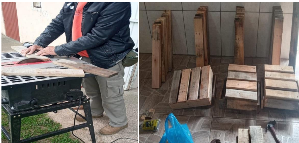
Figura 4: Corte, aplainamento e separação das peças para a montagem de cada lixeira. Fonte: Autores do Trabalho.
