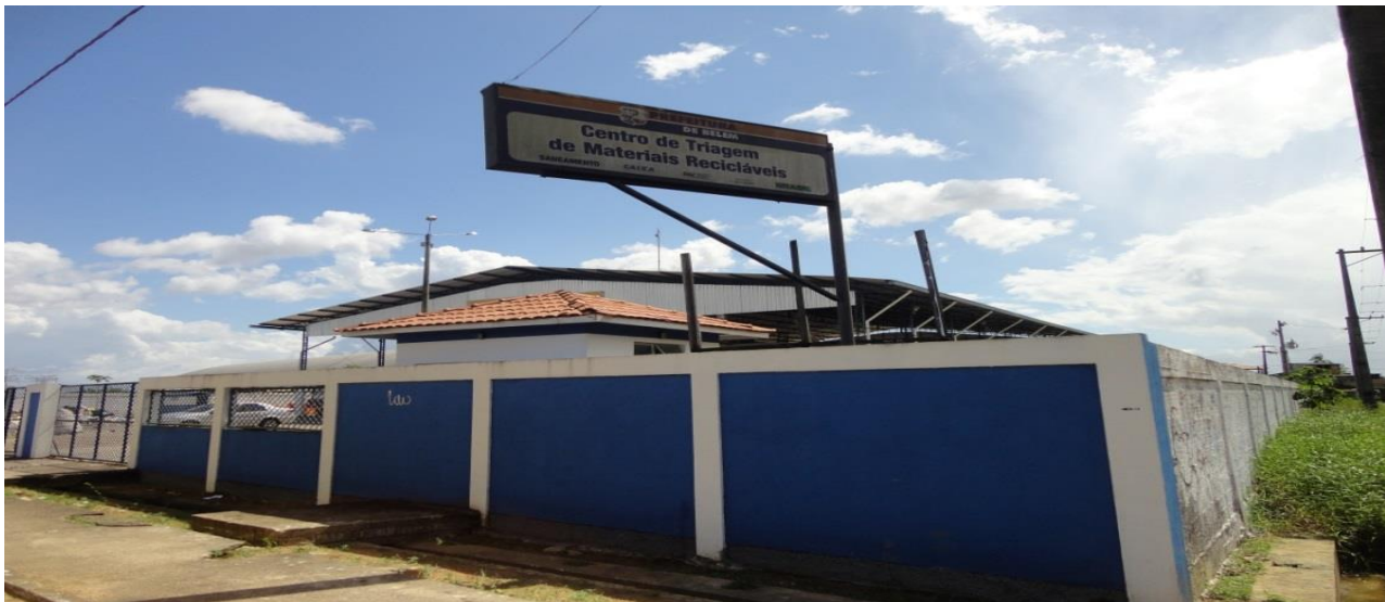
Figura 3: Galpão no Canal São Joaquim. Fonte: autora do trabalho
