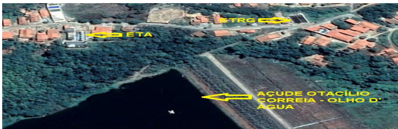
Figura 2: Localização da Estação de Tratamento de Água do Manancial de abastecimento. Fonte: Moreira, 2020
