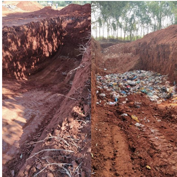
Figura 1-Vala aberta para deposição de resíduos
