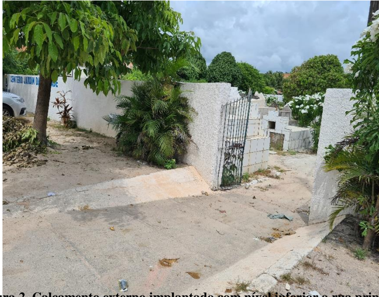
Figura 2. Calçamento externo implantado com nível inferior a rua principal da região, e um túmulo implantado no muro do Cemitério Jardim da Saudade, Tamandaré/PE. Fonte: Os autores (2022).
