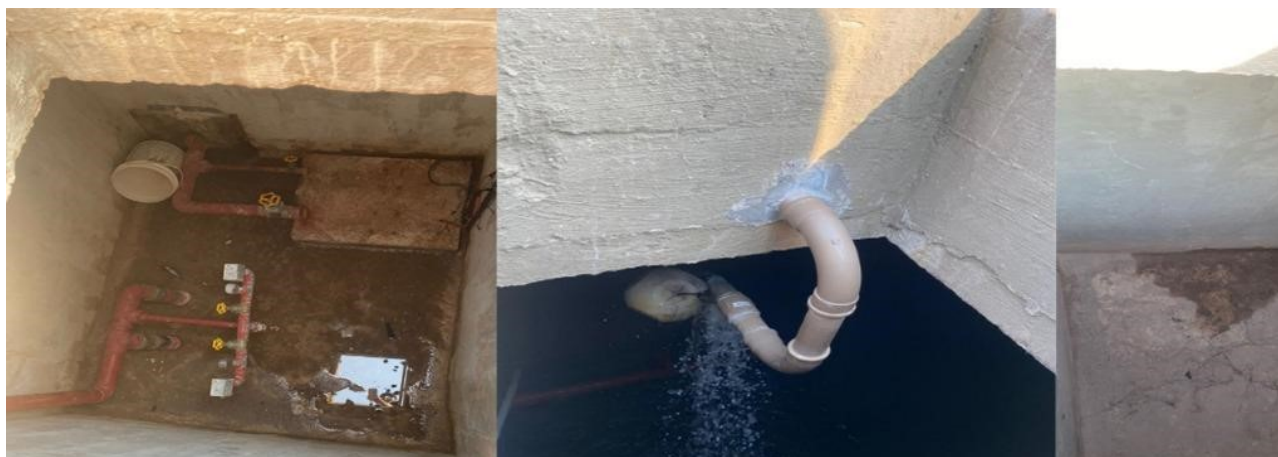
Figura 1: Registro fotográfico da cisterna desativada. Fonte: Autor do Trabalho.
