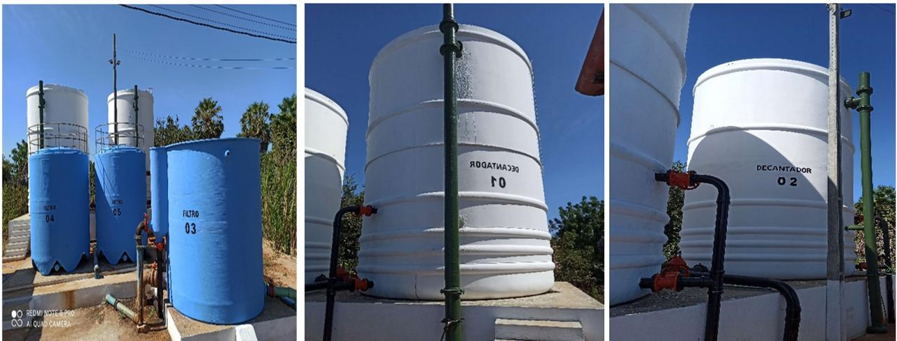
**Foto 02 – Filtros e floccodecantadores de fluxo vertical de alta taxa.**
