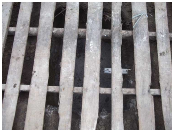
Figura 4 – Instrução sobre a limpeza dos sanitários (foto da esquerda) e “fossa negra” para efluente da pia (foto da direita). Fonte: Própria (2013)
