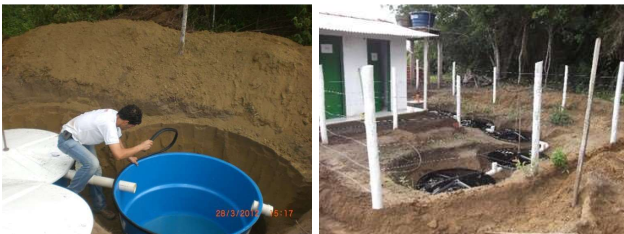
Figura 2 – Etapa de escavação e implantação do sistema, com detalhe para borracha de vedação instalada na borda da caixa (foto da esquerda). Na foto da direita o sistema já implantado e adaptado com 5 caixas. Fonte: Própria (2013)
