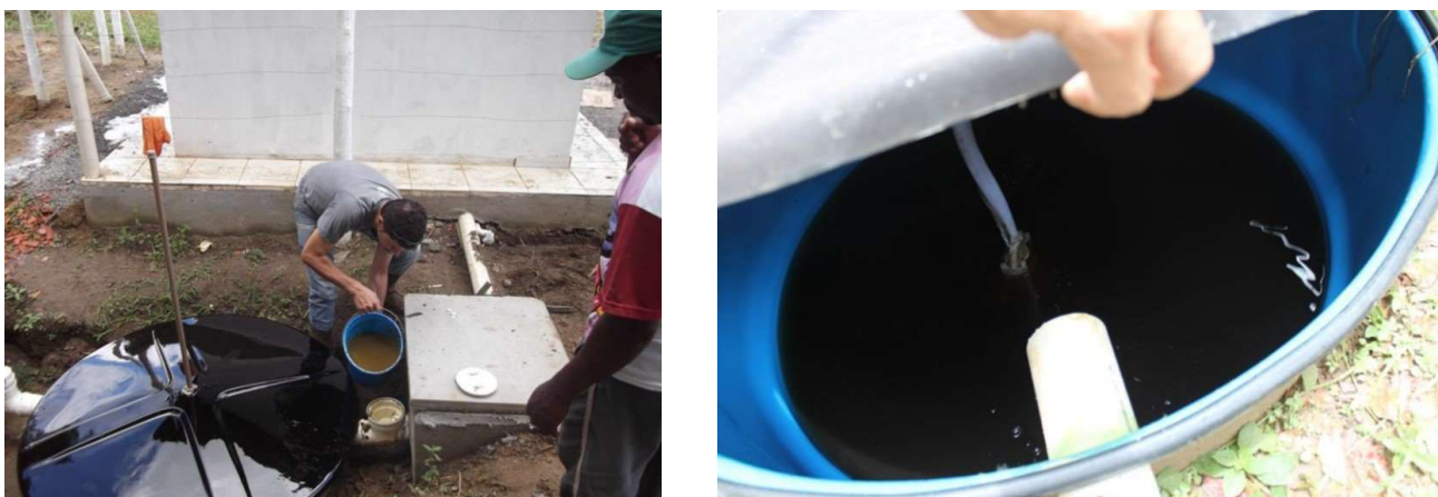
Figura 3 – Inoculação com esterco bovino na entrada do sistema (foto da esquerda) e detalhe da última caixa com a bomba para sucção do efluente tratado (foto da direita). Fonte: Própria (2013)
