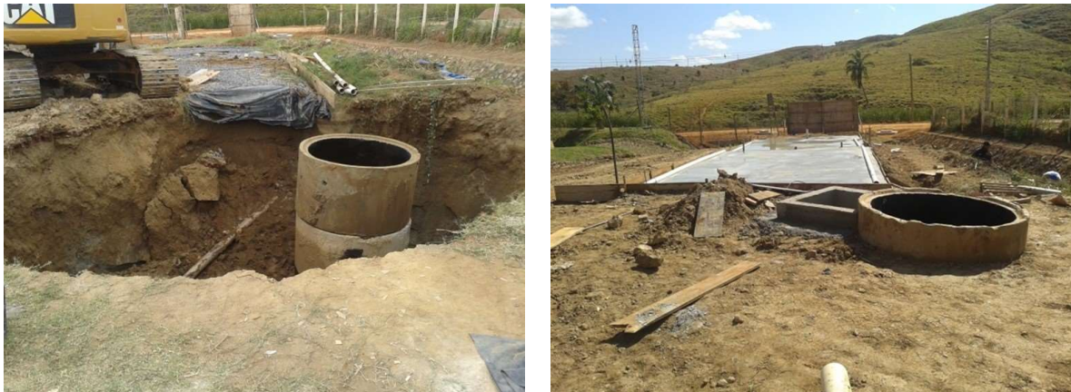
Figura 2 – Escolha e preparação do terreno para construção do Radier e ETE. Fonte: Própria (2015)
