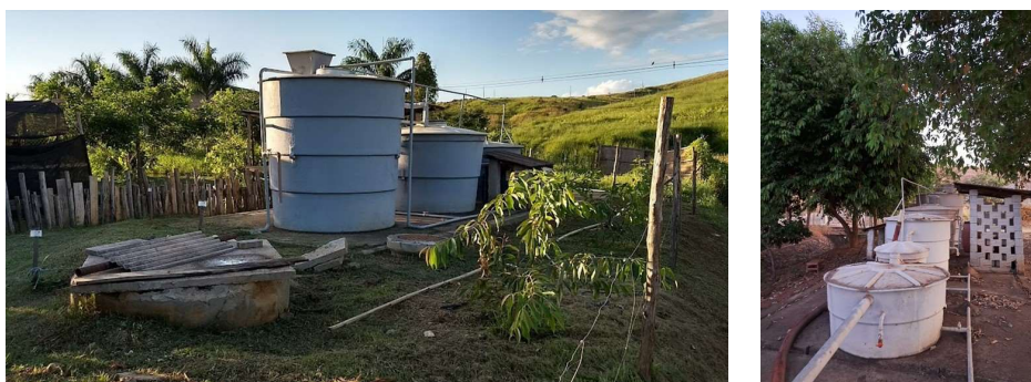
Figura 8 – Plantio de mudas no entorno da ETE (cinturão verde - 2017) e o efeito do cinturão verde para proteção dos tanques, em 2024 (à direita). Fonte: Própria (2017 e 2024)
