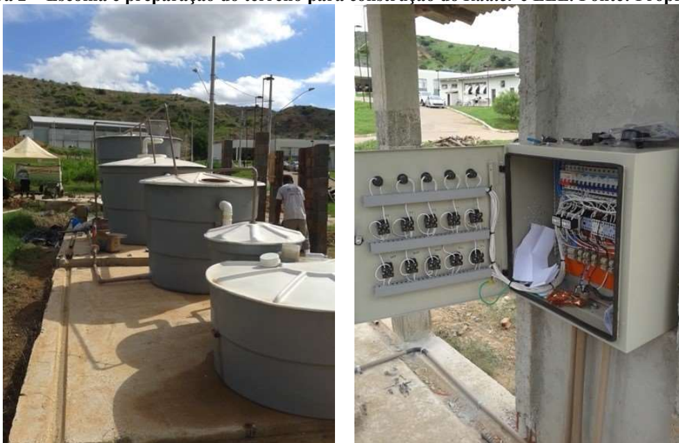
Figura 3 – Instalação hidráulica e Elétrica da ETE. Própria (2016)
