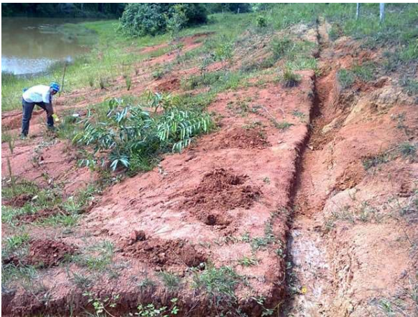
Figura 4 – Adoção de práticas mecânicas para contribuir com a proteção do solo dentro da APP (30 m da parte final dos 100m da margem da lagoa). À direita, o efeito benéfico da prática mecânica para conservação do solo e água. Própria (2013)
