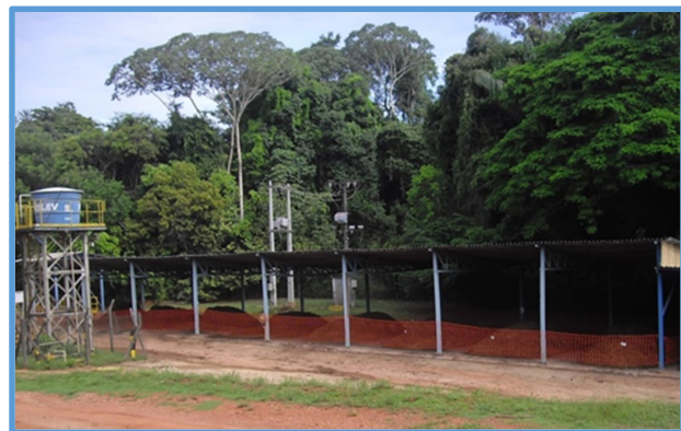
Figura 2: Unidade de Compostagem. Fonte: Autora.
