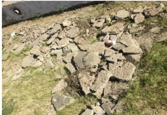
Figura 1: Resíduo encontrado na obra. Fonte: Autores, 2020.
