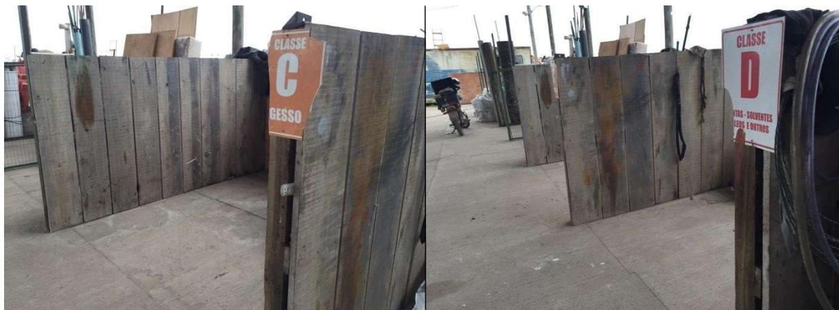
**Figura 5: Baia de acondicionamento de resíduos de Classe C e D. Fonte: Relatório Técnico solicitado na L.O nº 3986/2016.**
