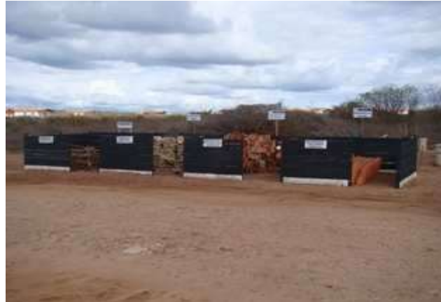
Figura 4: Baias para acondicionamento de resíduos de classe A e B. Fonte: Os Autores.
