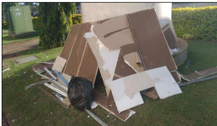
Figura 1: Resíduo de gesso acartonado em uma construção civil na cidade de Maringá-PR
