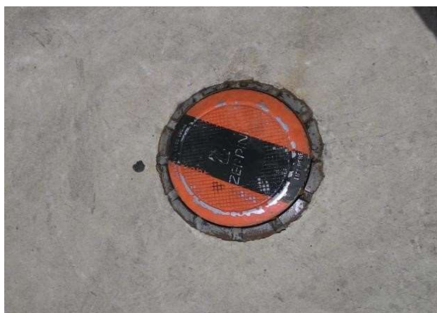
Figura 07 – Vista parcial da entrada do tanque de contenção de resíduos.Fonte: Autores(2023).
