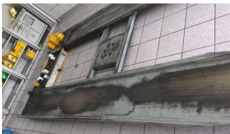
Figura 6–Piso impermeabilizante no local de troca de óleo.Fonte: Autores (2023).
