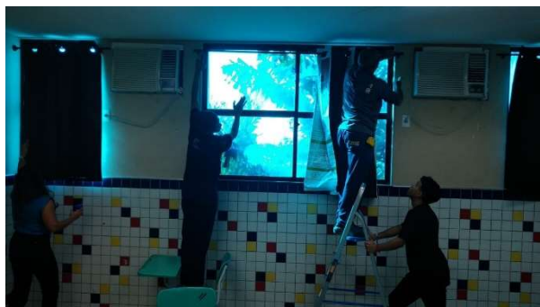
Figura 2 - Instalação das cortinas. Fonte: Autores, 2023.
