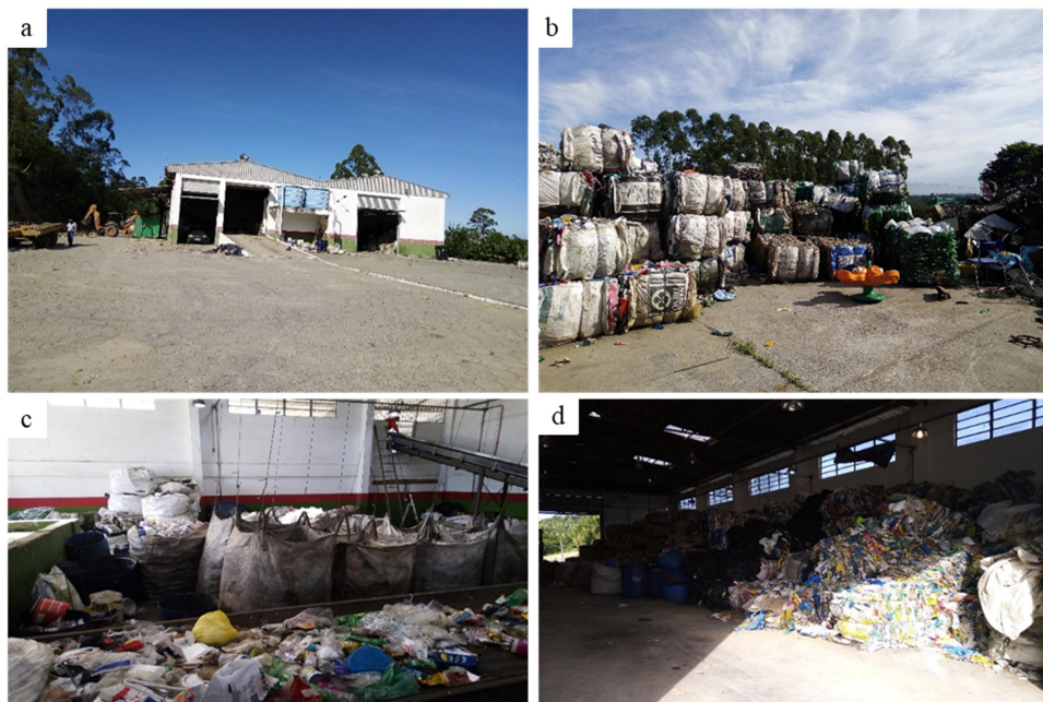
Figura 2: CTM: (a) pavilhão de triagem; (b) resíduos de materiais triados e armazenados a céu aberto; (c) esteira de triagem e sacos para separação; (d) resíduos triados armazenados no pavilhão. Fonte: Autor do Trabalho.
